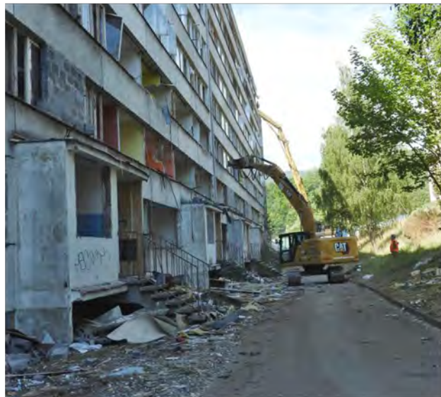
Demolice panelových domů na sídlišti Janov v Litvínově, 2022, zdroj: mulitvinov.cz.
