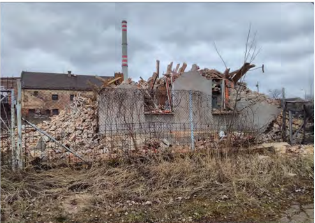
Brownfield Komořany, zdroj: databáze SEKM.
