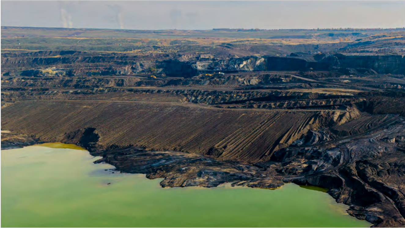
Sanace uhelné sloje Eliška I svahováním terénu a překrytím izolačními zeminami z alokovaných zemníků (foto Michal Porteš).
