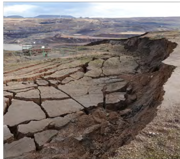
Rozsáhlý sesuv na severní hraně lomu ČSA v okolí ochranného pilíře arboretum Jezeří, autor Michal Porteš, prosinec 2023.
